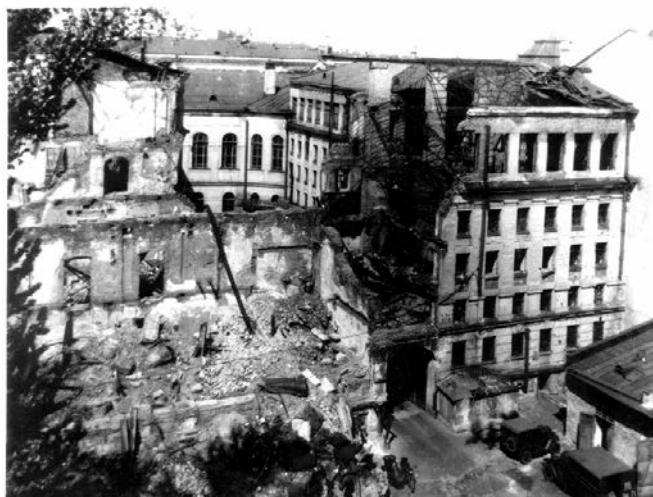
Разрушенное здание Ленинградской городской конторы Госбанка СССР со стороны двора. 1941 год
